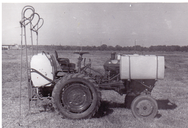
Фиг. 1. Първата българска пръскачка ОНК-62 (1962 г.)
