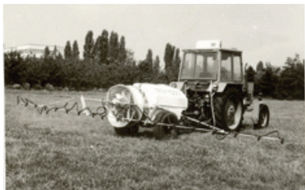
Фиг. 15. Пръскачка прикачна универсална ППУ-1000 Fig. 15. Sprayer trailed universal ППУ-1000
