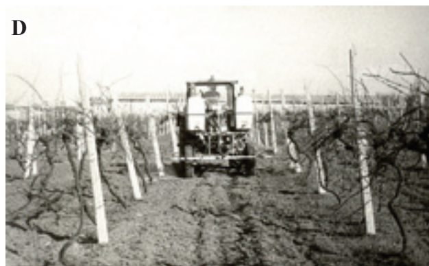
Фиг. 9. Универсална хербицидна уредба УХЛ-8М Fig. 9. Machines for treatment with herbicides УХЛ-8М
